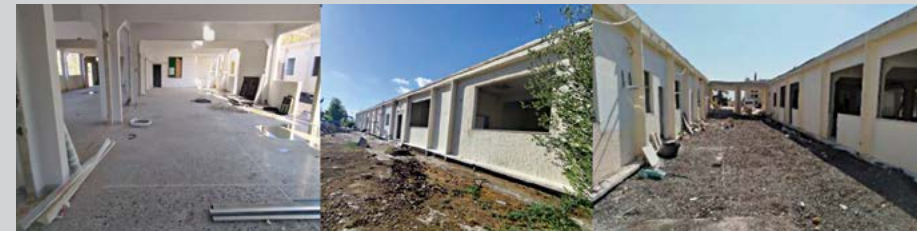
Μετατροπή πρώην Διοικητηρίου 75 ΜΕ σε 14 ΣΟΑ στο Στρατόπεδο «ΚΑΡΑΪΣΚΑΚΗ Β΄» στο Χαϊδάρι.
