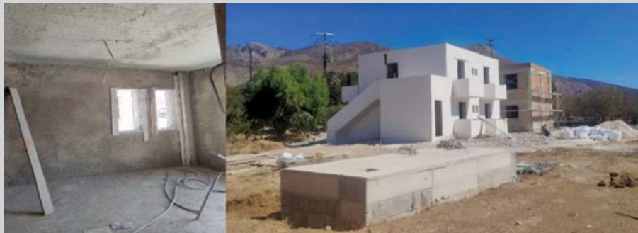
Κατασκευή ΣΟΑ 6 διαμερισμάτων στη ν. Τήλο.
