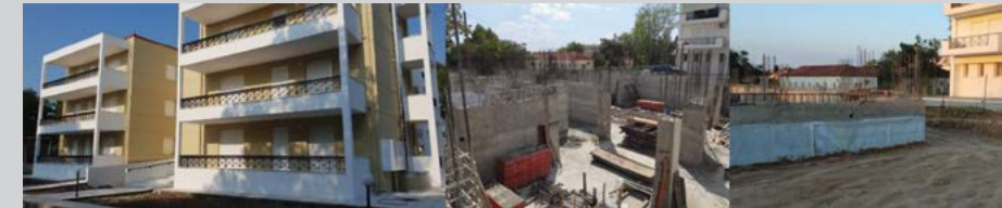
Κατασκευή ΣΟΑ 12 διαμερισμάτων στην Ορεστιάδα.
