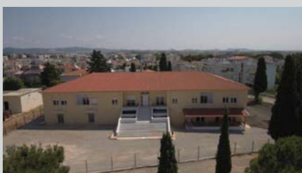
Διαμόρφωση 10 διαμερισμάτων σε υφιστάμενο κτήριο στο Στρδο «ΠΑΤΣΟΥΚΑ» στην Αλεξανδρούπολη.
