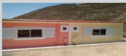
Κατασκευή 2 διαμερισμάτων στη Μεγίστη.
