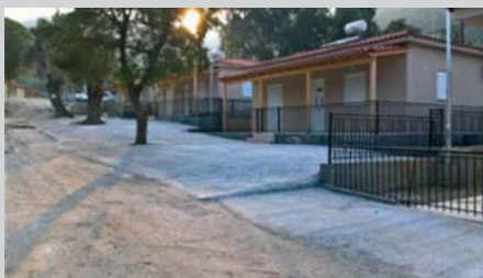
Κατασκευή 7 διαμερισμάτων στο Στρδο «ΠΟΛΥΖΩΝΗ» στη Λέσβο.
