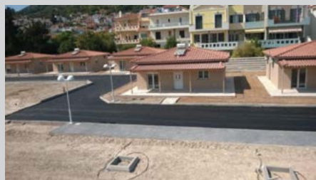
Κατασκευή 7 διαμερισμάτων στο Στρδο «ΚΑΡΛΟΒΑΣΙΤΗ» στη Σάμο.
