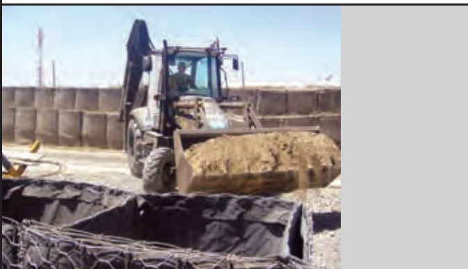
Κατασκευή αναχώματος στο ΚΑΙΑ
