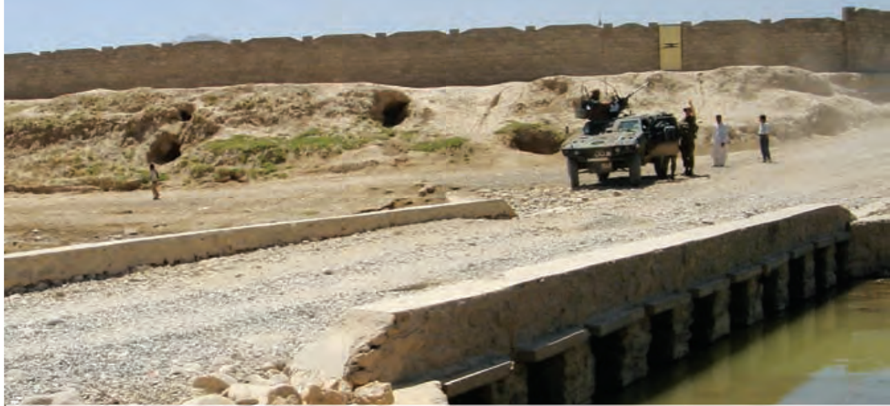
Αναγνώρισεις ΜΧ σε γέφυρα του δρομολογίου PEGASUS
