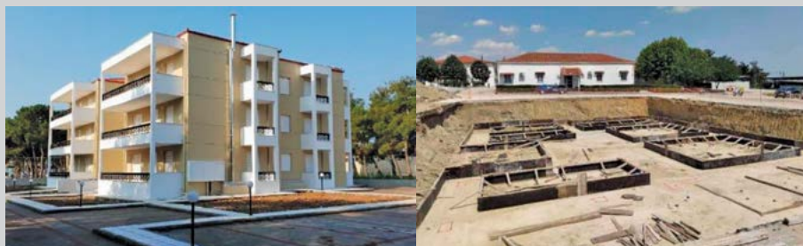
Κατασκευή ΣΟΑ 12 διαμερισμάτων στο Διδυμότειχο
