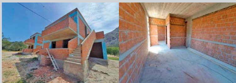
Κατασκευή ΣΟΑ 6 διαμερισμάτων στη ν. Τήλο
