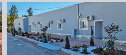
Κατασκευή 9 διαμερισμάτων ΣΟΕΠΟΠ στο Στρατόπεδο «ΚΑΡΑΪΣΚΑΚΗ Β΄»
