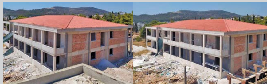
Κατασκευή ΣΟΑ 13 διαμερισμάτων στο Στρατόπεδο «ΚΑΡΑΪΣΚΑΚΗ Β΄» στο Χαϊδάρι (Β΄ Κτήριο)
