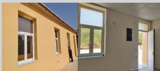
Κατασκευή 2 ξενώνων στο Στρατόπεδο «ΔΑΣΚΑΛΟΓΙΑΝΝΗ»
