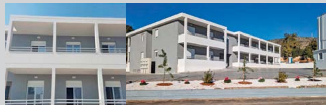
Κατασκευή ΣΟΑ 13 διαμερισμάτων στο Στρατόπεδο «ΚΑΡΑΪΣΚΑΚΗ Β΄» στο Χαϊδάρι (Α΄ Κτήριο)
