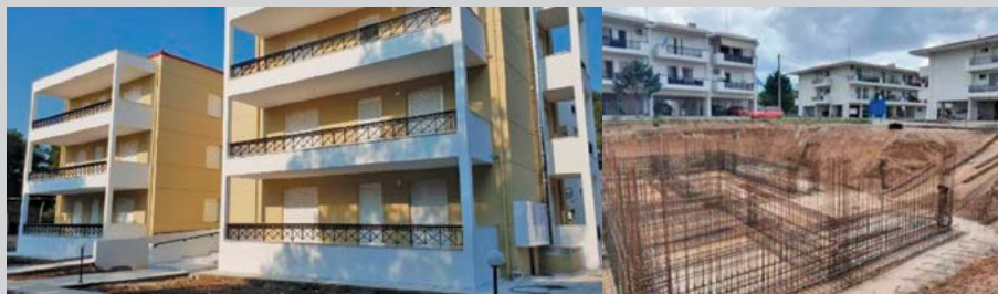
Κατασκευή ΣΟΑ 12 διαμερισμάτων στην Ορεστιάδα
