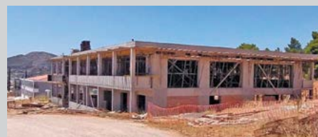
Κατασκευή ΣΟΑ 13 διαμερισμάτων στο Στρατόπεδο «ΚΑΡΑΪΣΚΑΚΗ Β΄» στο Χαϊδάρι (Γ΄ Κτήριο)
