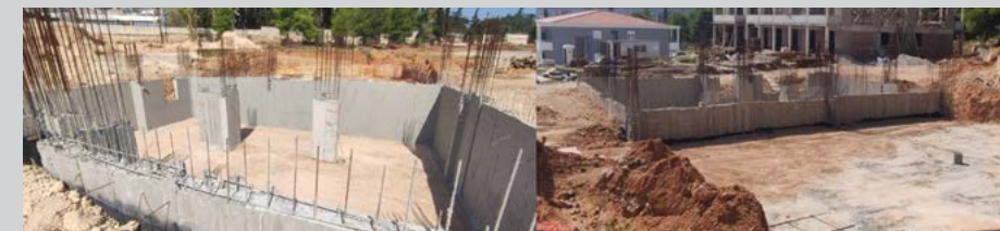
Κατασκευή 13 διαμερισμάτων στο Στρατόπεδο «ΚΑΡΑΪΣΚΑΚΗ Β΄» στο Χαϊδάρι (Γ΄ Κτήριο)
