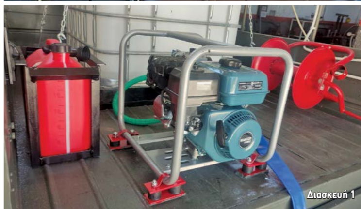
Επισκευή σε ΠΕΠ-ΠΕΜ 70 στη Ρόδο
