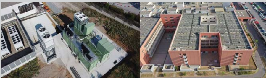
Ενεργειακή Αναβάθμιση του 424 ΓΣΝΕ. Τοποθέτηση Συστήματος Ηλιακής Ψύξης και Συστήματος Τριπαραγωγής BEMS.
