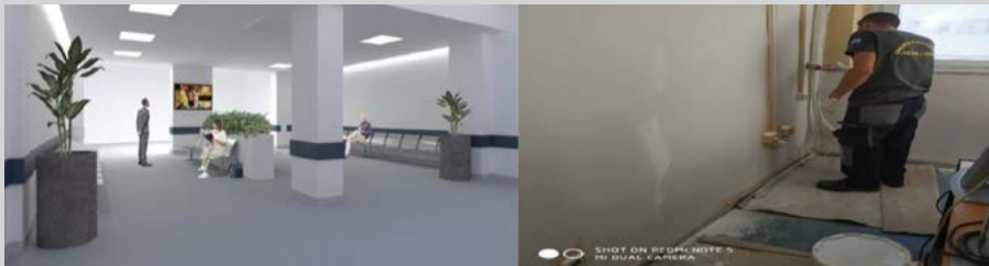
Συντήρηση-Αναβάθμιση Εξωτερικών Ιατρείων στο 401 ΓΣΝΑ. Εκτελούνται εργασίες από προσωπικό του Νοσοκομείου και της ΑΣΔΥΣ/ΔΜΧ.
