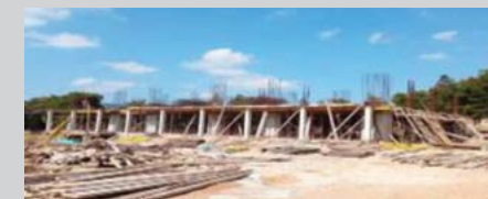
Κατασκευή ΣΟΑ 13 διαμερισμάτων στο Στρατόπεδο «ΚΑΡΑΪΣΚΑΚΗ», στο Χαϊδάρι (Β΄ Κτήριο).
