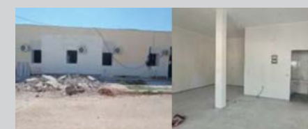
Κατασκευή 9 διαμερισμάτων ΣΟΕΠΟΠ στο Στρατόπεδο «ΚΑΡΑΪΣΚΑΚΗ Β΄».
