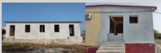
Κατασκευή 2 ξενώνων στο Στρατόπεδο «ΔΑΣΚΑΛΟΓΙΑΝΝΗ».
