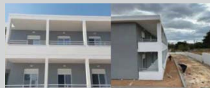
Κατασκευή ΣΟΑ 13 διαμερισμάτων στο Στρατόπεδο «ΚΑΡΑΪΣΚΑΚΗ», στο Χαϊδάρι (Α΄ Κτήριο).
