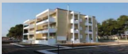
Κατασκευή ΣΟΑ 12 διαμερισμάτων στο Διδυμότειχο.
