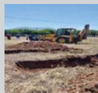
Κατασκευή ΣΟΑ 6 διαμερισμάτων στη ν. Τήλο.
