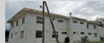
Ανακατασκευή δώροφου κτηρίου σε ΣΟΑ 6 διαμερισμάτων (Πρώην Διοικητήριο 5ου ΤΥΠ).
