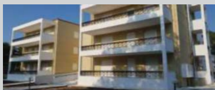
Κατασκευή ΣΟΑ 12 διαμερισμάτων στην Ορεσιάδα.
