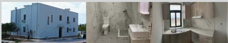
Κατασκευή ΣΟΕΠΟΠ 4 διαμερισμάτων στο Στρατόπεδο «ΚΑΡΑΪΣΚΑΚΗ», στο Χαϊδάρι.
