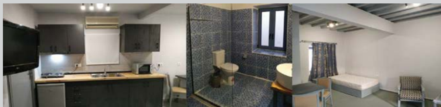
Ανακατασκευή κτηρίου και δημιουργία δύο διαμερισμάτων στην Κάσο.
