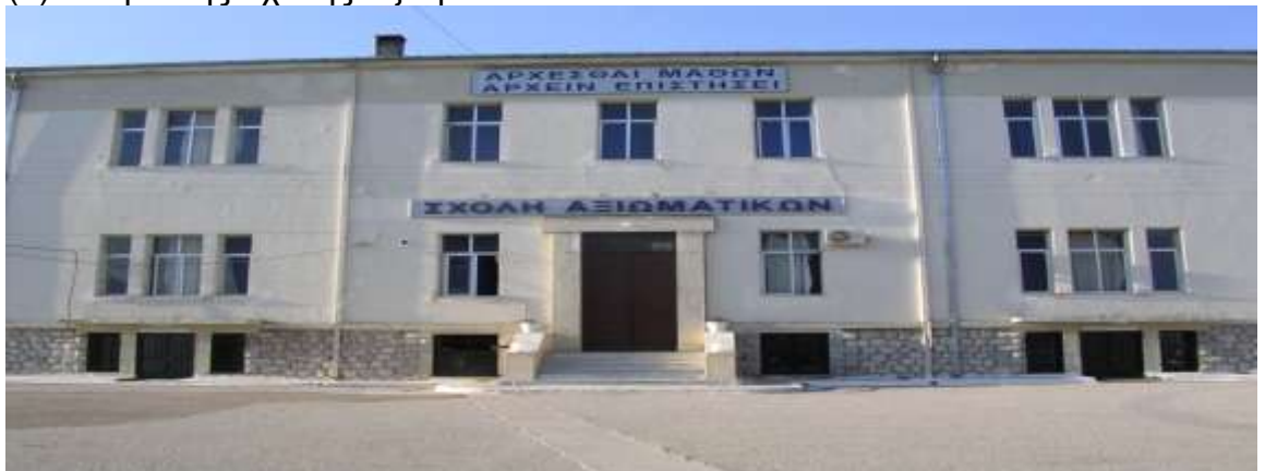
(3) Κτίριο της Σχολής Αξιωματικών
