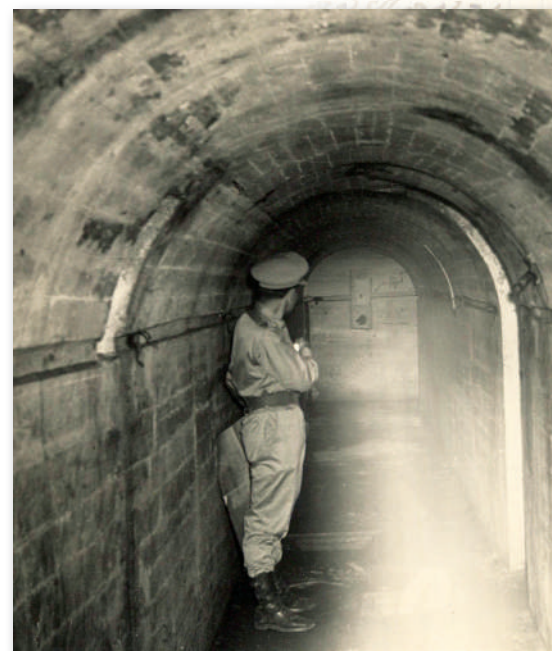
Υπόγεια στοά στο οχυρό Ιστίμπεη, στο όρος Κερκίνη (Φωτογραφικό αρχείο ΓΕΣ/ΔΙΣ).
