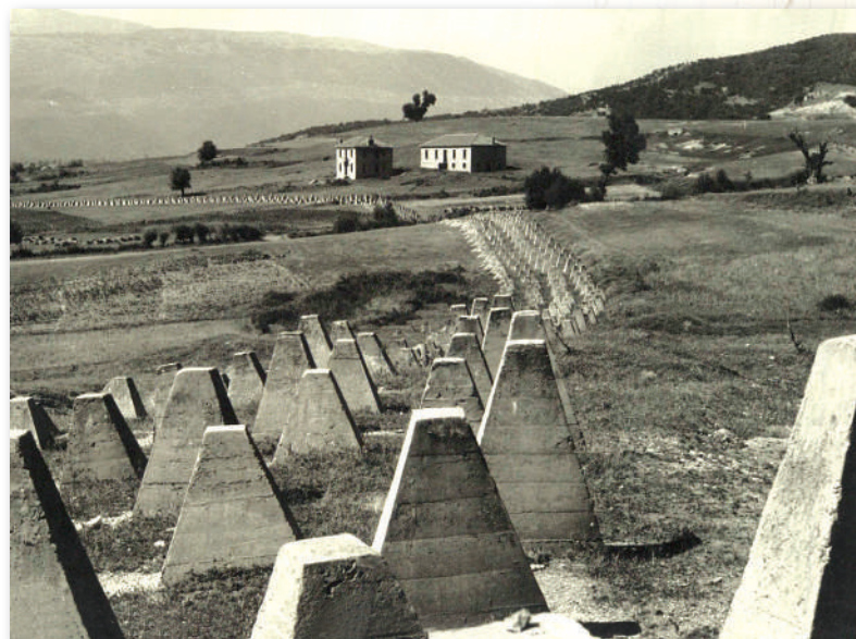
Αντιαρματικά κωλύματα στο οχυρό Παρταλούσκα, βόρεια της Κάτω Βροντούς Δράμας (Φωτογραφικό αρχείο ΓΕΣ/ΔΙΣ).
