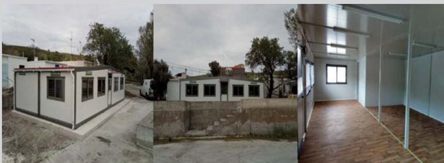
Κατασκευάστηκε χώρος Διοικητικής Μέριμνας στην ε/ν του Αγίου Ευστρατίου επ' ωφελεία της Δημοτικής Αρχής (Εγκατάσταση οικίσκου 70 τ.μ.).
