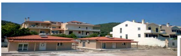
Διαμόρφωση 7 οικημάτων με τη χρήση προκατασκευασμένων στοιχείων στο Στρδο «ΚΑΡΛΟΒΑΣΙΤΗ» στη Σάμο.
