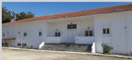
Ανακατασκευή ανενεργού κτηρίου και διαμόρφωση 8 διαμερισμάτων στο Στρώο «Δημουλά» στη ν. Λήμνο.
