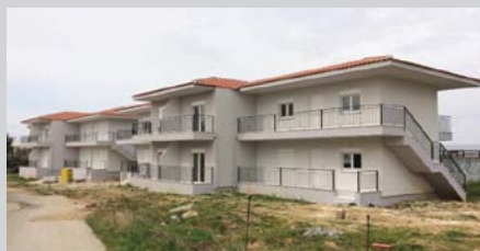
Κατασκευή 8 διαμερισμάτων στο Στρώο «ΠΑΡΑΣΧΟΥ» στην Κομοτηνή.
