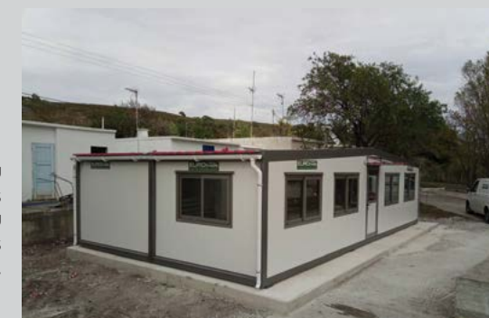
Κατασκευή Χώρου Διοικητικής Μέριμνας στην ε/ν του Αγίου Ευστρατίου επ' ωφελεία της δημοτικής αρχής (Εγκατάσταση οικίσκου 70 τ.μ.).
