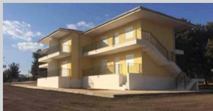
Κατασκευή 8 διαμερισμάτων στο Στρώο «ΠΑΤΣΟΥΚΑ» στην Αλεξανδρούπολη.
