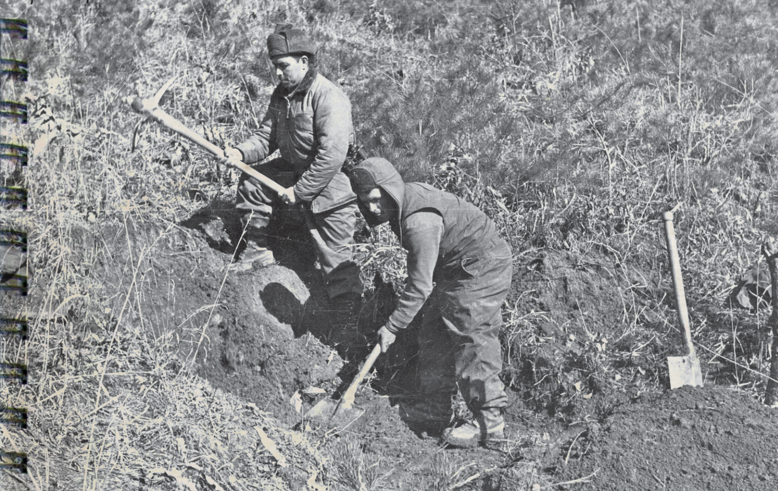
Οργάνωση εδάφους στον σταθμό Α΄ βοηθειών του τάγματος (ΣΑΒΤ) νοτίως του Υψ. 381 (Πηγή: Φωτογραφικό αρχείο ΓΕΣ/Δ4 - ΔΙΣ)
