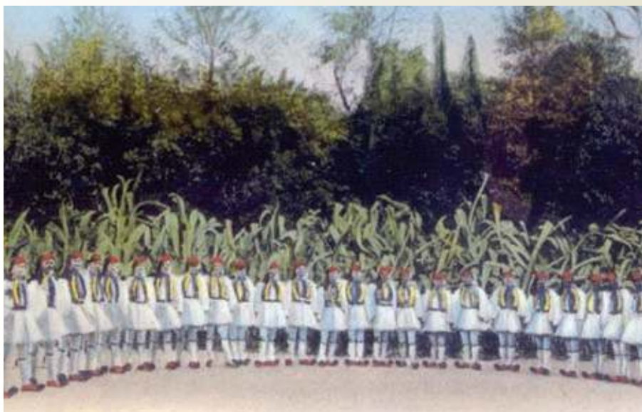
Περίοδος προ του 1908 – Επιστολικό δελτάριο με χορό Ευζώνων της Ανακτορικής Φρουράς κατά τον εορτασμό του Πάσχα. (Αρχείο Ε.Λ.Ι.Α.)
