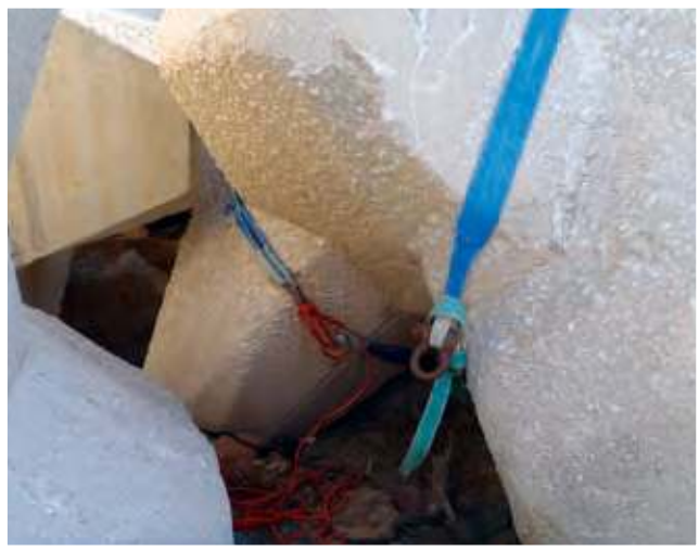
Τοποθέτηση Ακροποδών στην περίμετρο του λιμανιού
