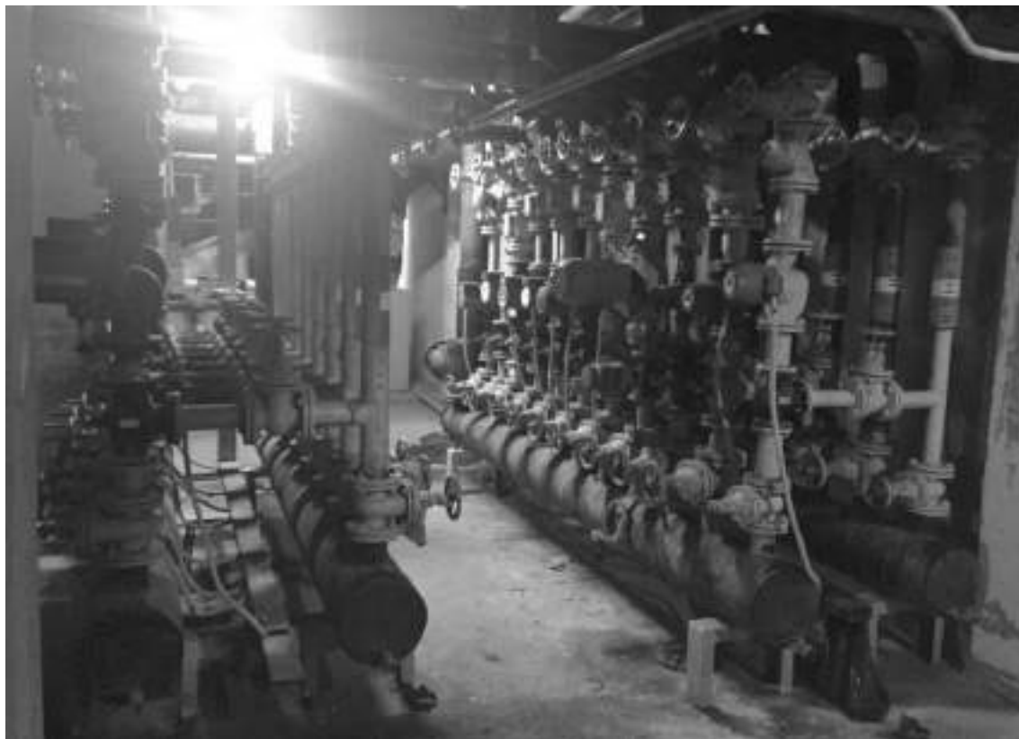
Εικόνα 2.4.14: Επιμέρους Διανομείς Θερμού Νερού (No 1 και No 2, από δεξιά προς τα αριστερά)
