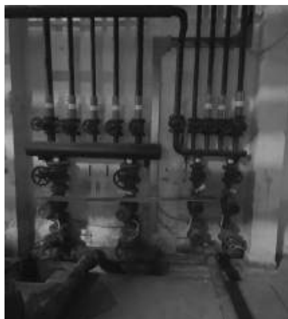
Εικόνες 2.4.12: Κεντρικοί Διανομείς - Συλλέκτες Θερμού Νερού
