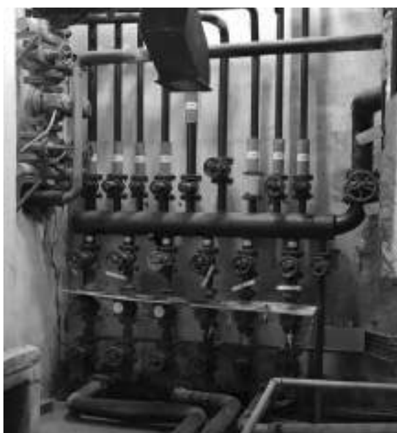
Εικόνες 2.4.12: Κεντρικοί Διανομείς - Συλλέκτες Θερμού Νερού
